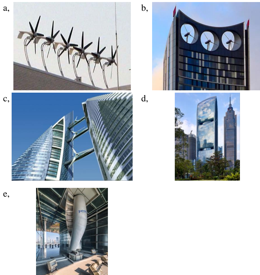
6. ábra. Épültre és épületekbe integrált szélturbinák. a, Szélturbinák egy lakóház tetején [27]; b, Strata SE1 torony szélturbinái [28]; c, Bahreini Világkereskedelmi Központ szélturbinái [29]; d, Gangzhoui Perl River torony [30]; e, Gangzhoui Perl River torony egyik szélturbinája [30]
