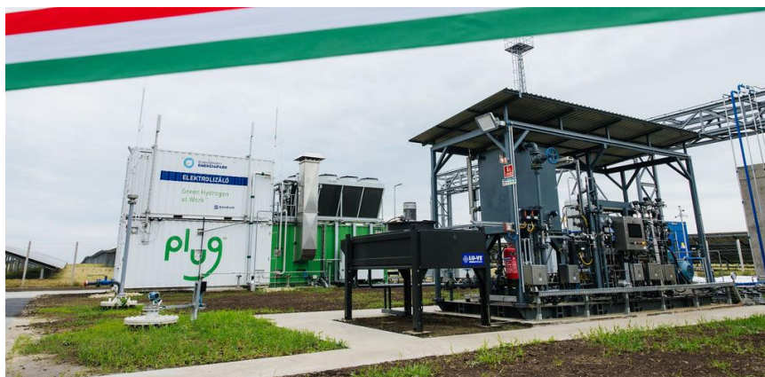
14. ábra: Előtérben a kisnyomású puffertartály és a kompresszor, háttérben az elektrolizáló [110] (szerkesztett).
