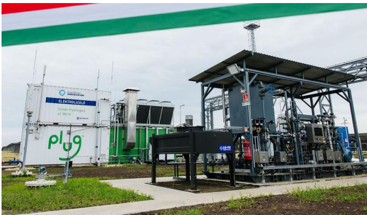
12. ábra: Előtérben a kisnyomású puffertartály és a kompresszor, háttérben az elektrolizáló [110] (szerkesztett)
